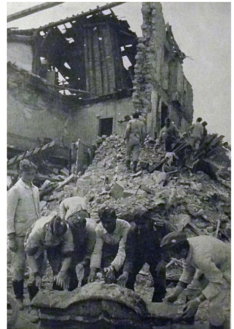
Der Reichsarbeitsdienst baut wieder auf. Zu Räumungs- und Aufbauarbeiten wurde in allen vom Kriege zerstörten Gebieten der Reichsarbeitsdienst eingesetzt, der die Spuren des Kampfes beseitigt (Quelle: SIGNAL Juli 1940)
